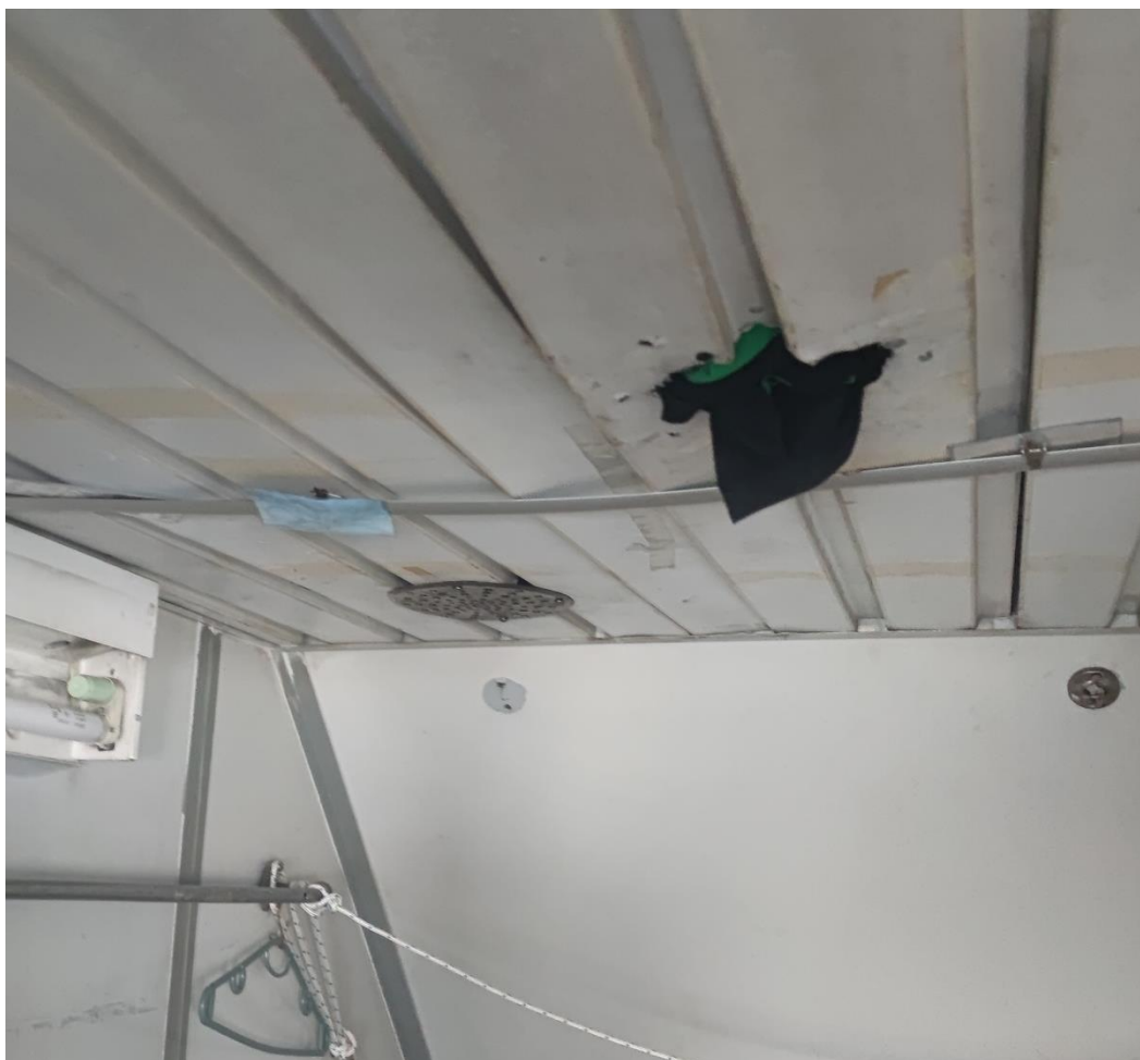
Slika 7. Oštećenje na stropu jedne od kabina
